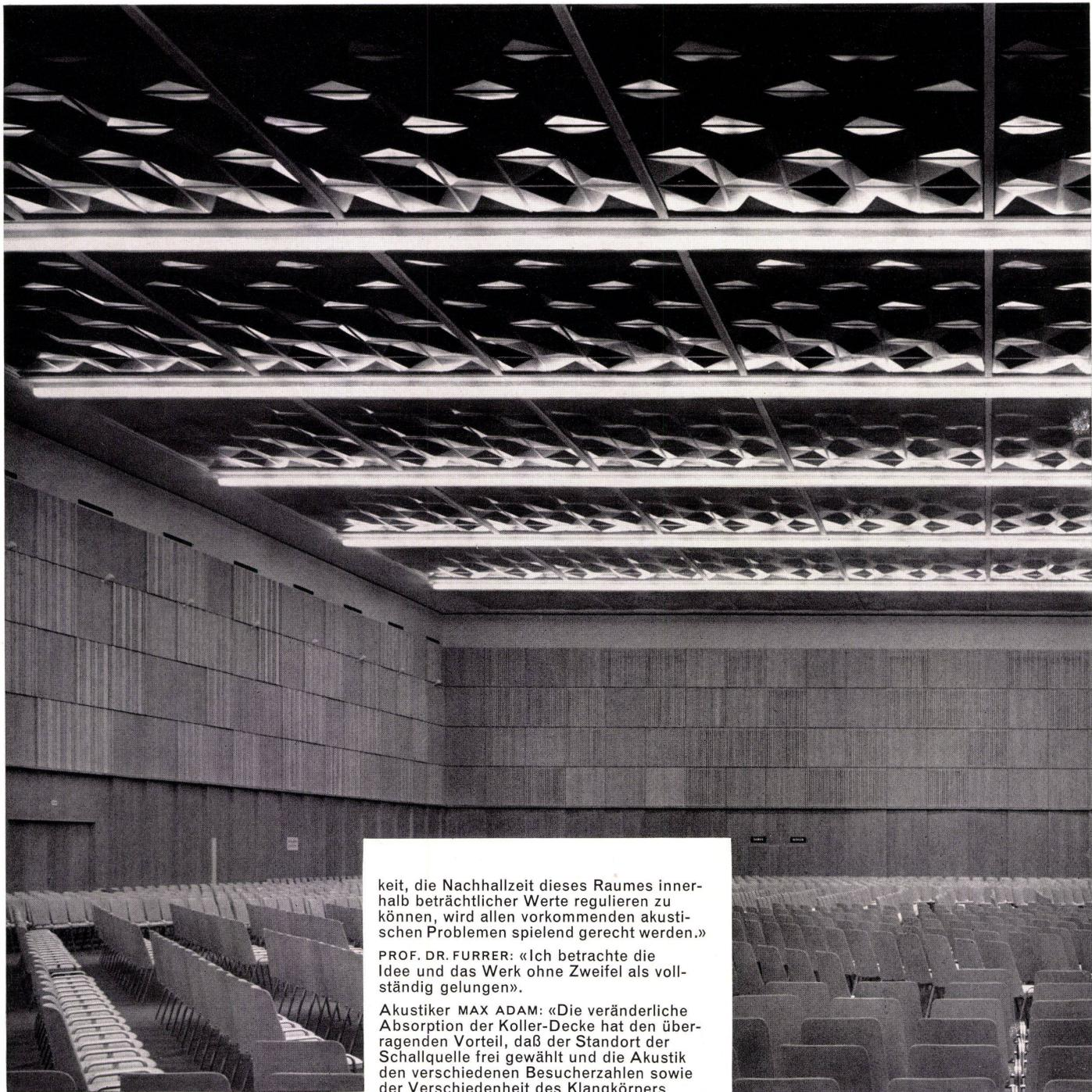
Die erste bewegliche, geräuschlos funktionierende, 3200 m<sup>2</sup> große Akustikdecke der Welt. Eine Prüfung der Kongreßhalle Basel (Raumvolumen 42 000 m<sup>3</sup>) durch 40 Experten hat für die Koller-Decke folgende Resultate ergeben:
