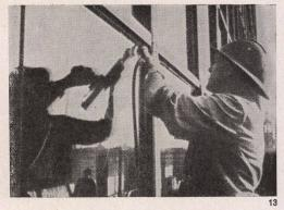
12 Die Rahmen werden aufeinandergesetzt und mittels Klemmleisten gegen die Pfosten gepreßt. Die Dichtungsschnur aus dauerplastischem Kitt ist dazwischen erkennbar.
