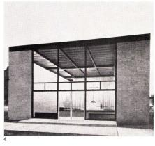
Gerippe aus Stahlbeton, das mit Bruchsteinen ausgefacht ist. Es handelt sich nicht um eine Schwerkraftmauer, wie man denken könnte (Abb. 5). Das Dach erscheint als Hängedach, ist aber von elf verdeckten Stahlbetonbalken getragen. Konstruktion und formale Erscheinung stehen somit nicht in unmittelbarer Wechselbeziehung.
