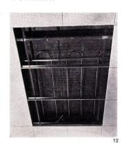
Die beiden je für sich abstell- und entleerbaren Hauptgruppen besitzen automatische Dreiwegventile, die entsprechend der Außentemperaturen von Hand auf die nötigen Heizwasservorlauftemperaturen einzustellen sind. In die Hauptleitungen der beiden Untergruppen Südfassade und Westfassade sind zudem Motordrosselklappen eingebaut, die, von Raumthermostaten gesteuert, bei Übertemperaturen im Raum durch Sonneneinstrahlung die Heizwasserzirkulation dieser Gruppen unterbrechen.
