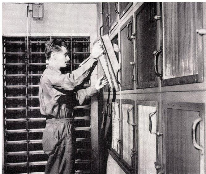
Der Sulzer Service-Mann wechselt in bestimmten Zeitabständen die Luftfilter in den Klima- und Lüftungsanlagen aus.
