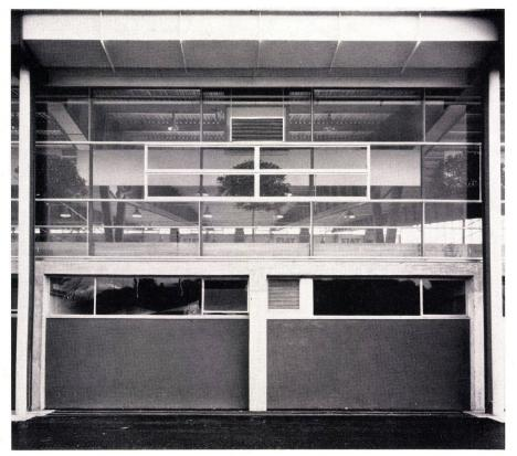
Fassadenausschnitt vor einer Umkleidekabine der Spieler und der Glashaut im Rücken der kleinen Rampe über den Spielerkabinen. Die Frischluft bzw. die Abluft wird direkt durch Gitter angesogen bzw. ausgeblasen, die an Stelle von Glas in die Fenster eingesetzt sind.
