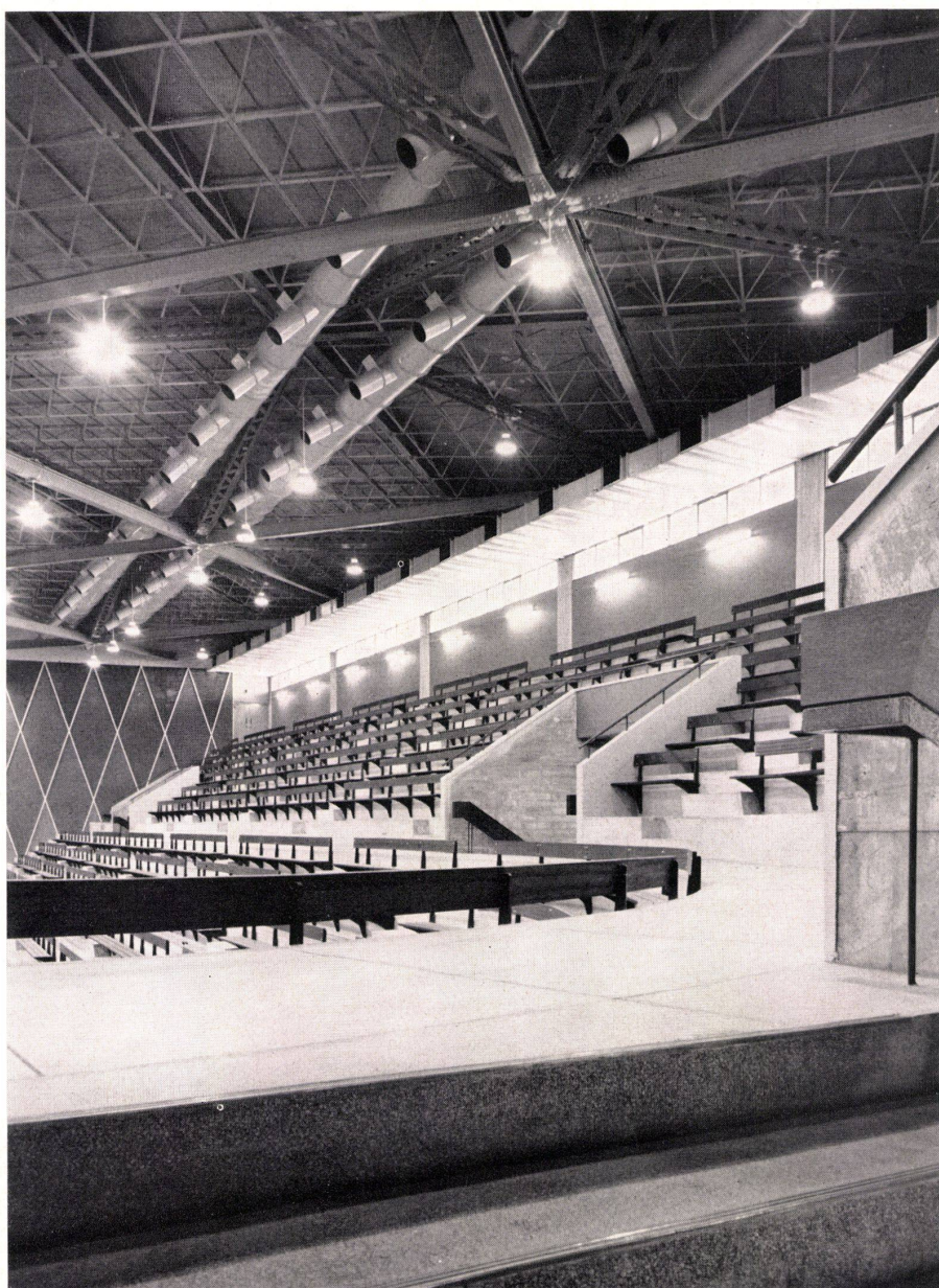
Umgang auf dem 1. Obergeschoß. Die Luft wird in zylindrischen Kanälen unter dem Trägerwerk in die Halle befördert und von dort in Rohrstützen ausgeblasen. Galerie du 1er étage. Des canaux cylindriques amènent l'air sous les sommiers en treillis et le soufflent dans la halle. Gallery on first floor. Air is introduced into the hall by cylindrical ducts under the girders and from there blown into hollow supports.
