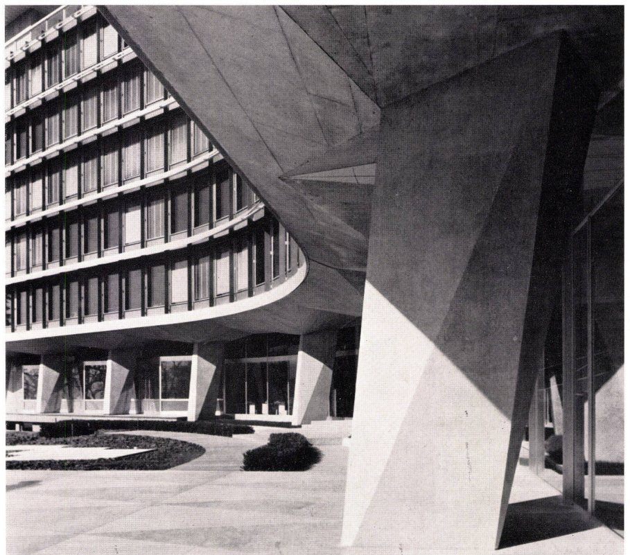
Ausschnitt des Betontisches auf der Nordseite, auf den die Stahlkonstruktion der sechs Obergeschosse abgestellt ist. Partie de la table de béton, sur le côté nord, sur laquelle sont posés les 6 étages de construction métallique. Detail of concrete table on north side, on which rests the steel construction of the six floors.
