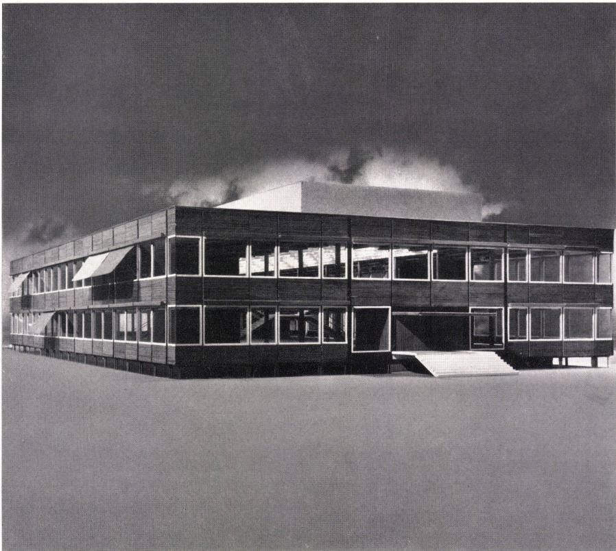
geneigten Shedflächen verglast werden müssen, wenn während der Wintermonate eine gute Tagesbelichtung des Mittelbereichs erzielt werden soll. Die Ausleuchtung ist etwa 2,6fach besser als bei senkrecht verglasten Flächen. Damit eine direkte Sonneneinstrahlung und Blendung vermieden wird, ist über den Sheds ein horizontal liegender Raster vorgesehen. Unterhalb der Shedkonstruktion und oberhalb des Akustikrasters wird eine Staubdecke aus lichtstreuendem Glas eingebaut.
