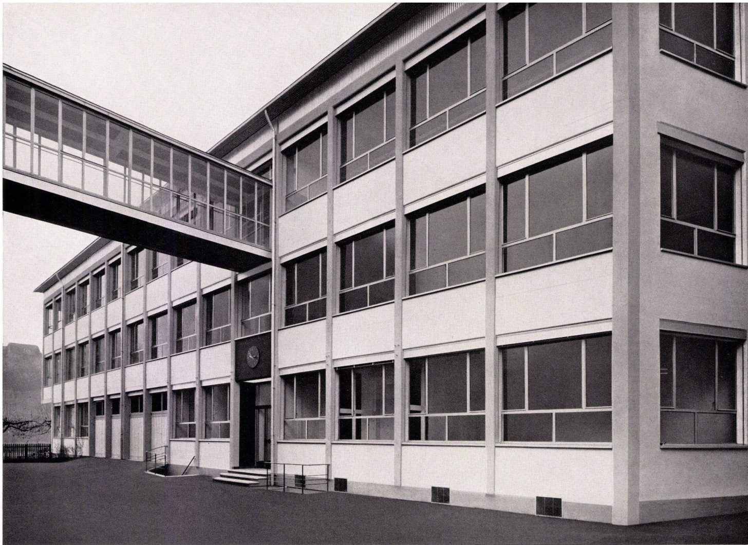
Uhrenfabrik mit Klimaanlage, Fenster in isolierter Leichtmetall- konstruktion ALSEC
