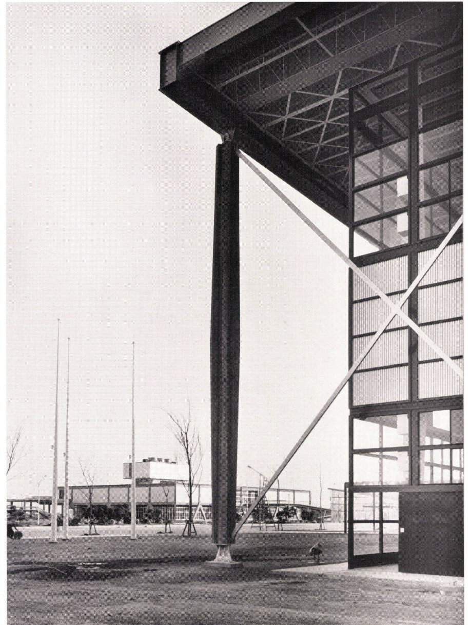
4 Vorfabrizierte Pendelsäule aus Stahlbeton der Halle 1. Im Hintergrund Halle 3. Colonne articulée préfabriquée en béton d'acier de la halle 1. Au fond hall 3. Prefabricated column with ball and socket seating of steel concrete of hall 1. In the background hall 3.
