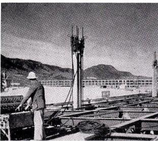
1 Das zwischen den Pfeilern auf dem Boden montierte Hängewerk.
