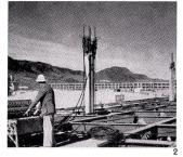
Das zwischen den Pfeilern auf dem Boden montierte Hängewerk,
