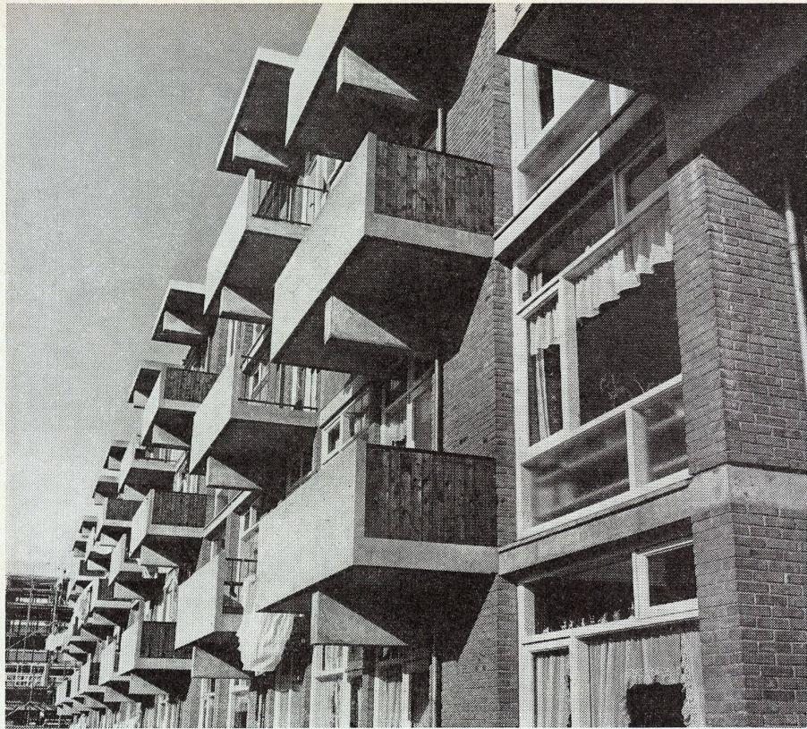
1 Die Balkone sind gleich wie das Mauerwerk und die Decken, als vorfabrizierte Elemente montiert.
