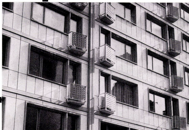
Fassaden-Fertigelemente, Stärke 18 cm, k = 0.70 \text{ kcal/m}^2\text{h}^\circ\text{C} , Gewicht nur 145 \text{ kg/m}^2 Entwurf: W. & M. Ribary, Arch., Luzern
