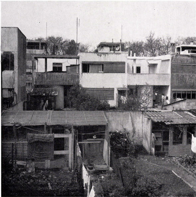
2 Blick in den ehemaligen Grünraum zwischen den beiden Hauszeilen. Die Kleintierställe und Garagen wecken Erinnerungen an eine «bidonville».
