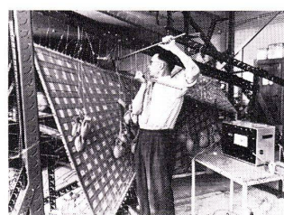
10 Das Vorspannen des Sperrholzmodells.
