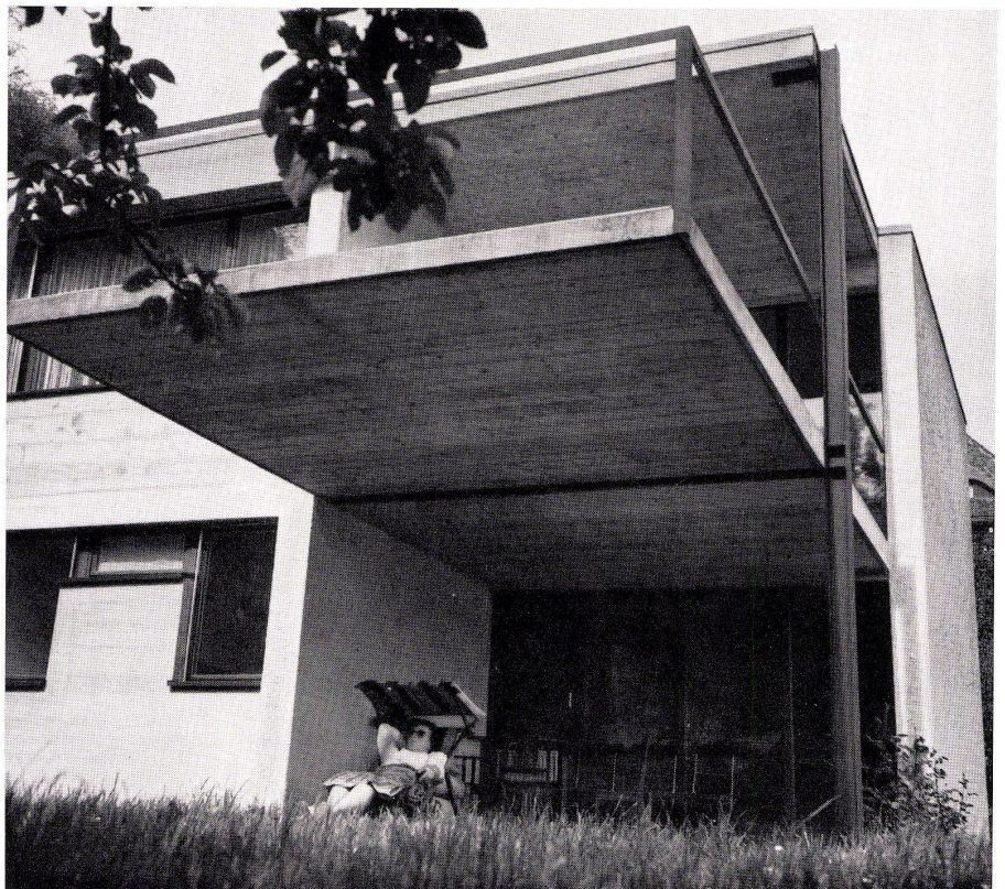
1 und 2 Gedeckter Sitzplatz im Freien vor dem Unterrichtszimmer. Séjour couvert en plein air devant la salle des leçons. Open-air covered seating area in front of the classroom.
