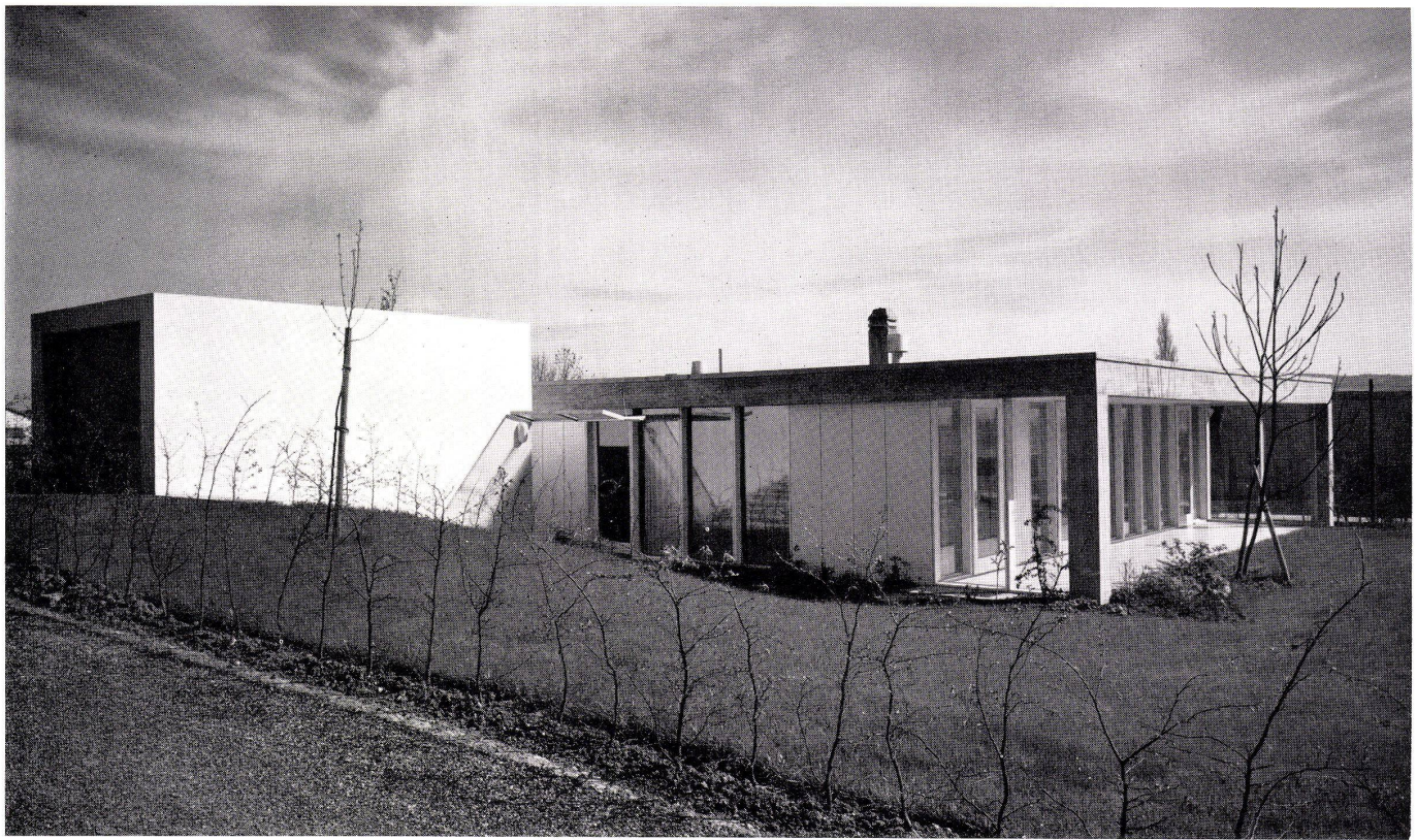
1 Eingangsfassade mit Garage links und gedecktem Sitzplatz rechts. Façade d'entrée; garage à gauche et séjour couvert en plein air à droite. Entrance elevation with garage left and covered seating area right.
