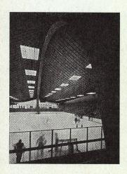
Schnitt durch den großen Stahlbeton-bogen im Bereich der Kabel als Dach-träger.
