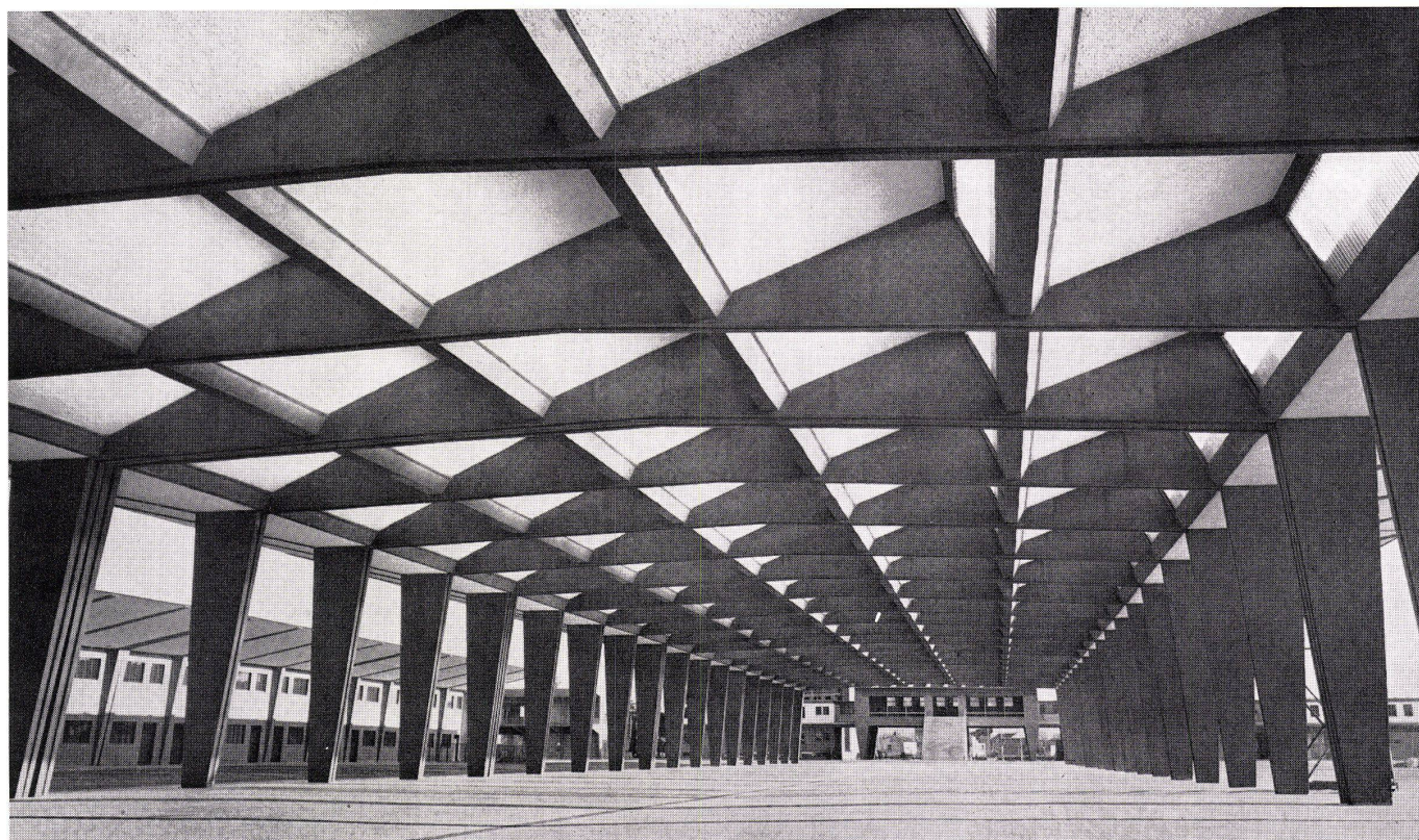
Dachuntersicht der Großmarkthalle (siehe Konstruktions- blatt). Face inférieure du toit des halles (Voir plan détachable). Underside of roof of market shed (See design sheet).
