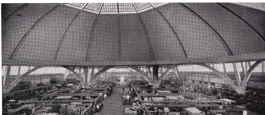
6 Durchdringung von zwei Zylinderschalen in der Art eines Kreuzgewölbes. Flughafen St. Louis, Empfangsgebäude. Architekten G. F. Hellmuth, J. W. Leinweber und M. Yamasaki. (Entnommen aus L'architettura cronaca e storia, 1957). Intersection de deux coquilles cylindriques dans le genre d'une voûte croisée. Aéroport St. Louis. Bâtiment de réception.
