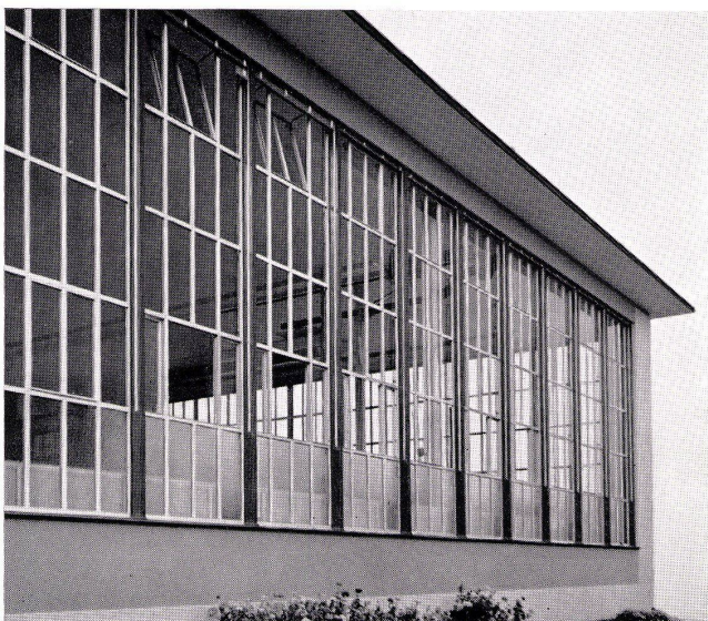
ALSEC-Leichtmetallprofile K = 2,25 – 2,5 Isolierglas-Elemente K = 2,5 – 3,0
