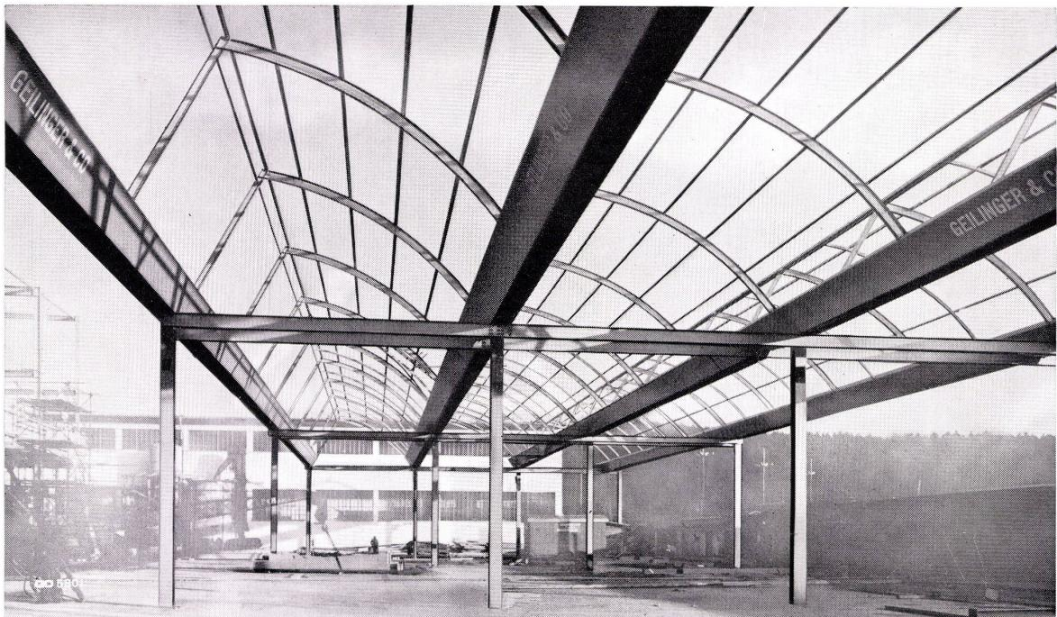
Shedkonstruktion mit rinnenförmigen Hauptträgern (+ Pat. angem.)
