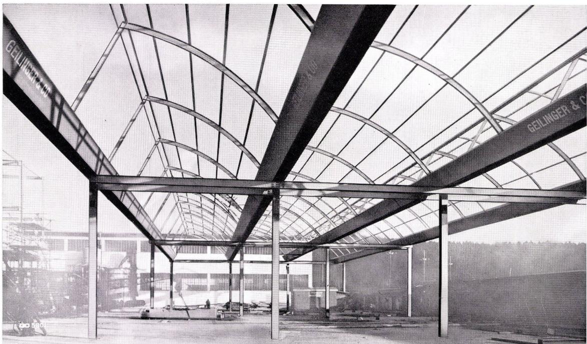
Shedkonstruktion mit rinnenförmigen Hauptträgern (+ Pat. angem.)
