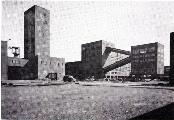
Schachanlage Katharina der Essener Steinkohlenwerke 1952 bis 1954. Links Schachthalle und Turmförderung, rechts Wäsche und Eckturm mit Transportbändern.
