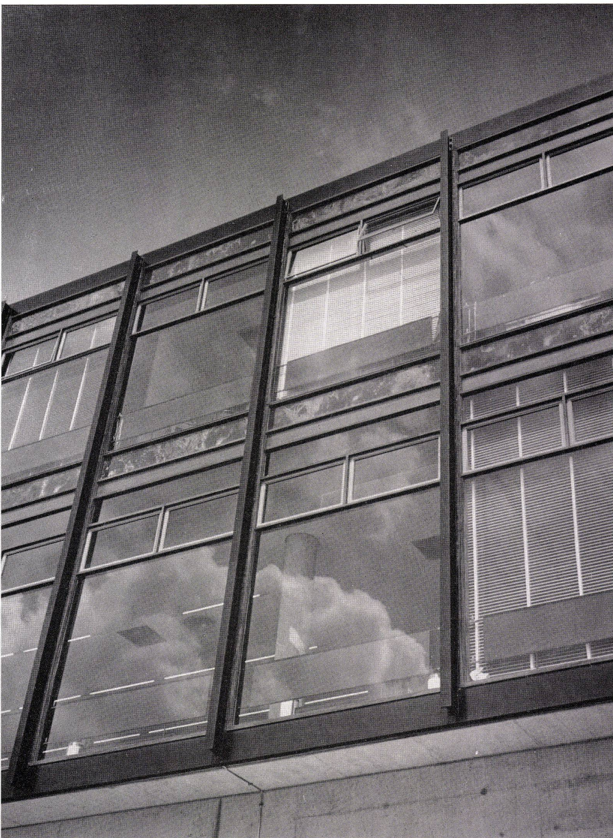
1 Aufnahmegebäude von Osten. Rechts der geschlossene Verbindungsgang zur Bahnstation. Die Aufnahmehalle befindet sich im ersten Obergeschoß.
