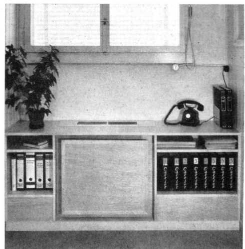
Konvektor in Fensternische verschalt
