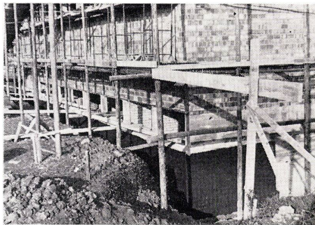
Neue Turnhalle Marthalen: Fundament-Isolation mit AFRATAR
