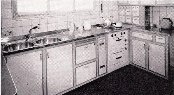
Einbauherde, Boiler, Schrankunterbauten und Spültablettabdeckungen in selbsttragender, genormter Elementbauweise. Verlangen Sie unverbindlich unsere Vorschläge und Planunterlagen.
