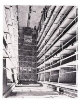
Blick in die Liftturmhalle mit Parkboxen zu beiden Seiten. In der Mitte Lifttürme mit Förderanlagen von Mohr & Federhaff.
