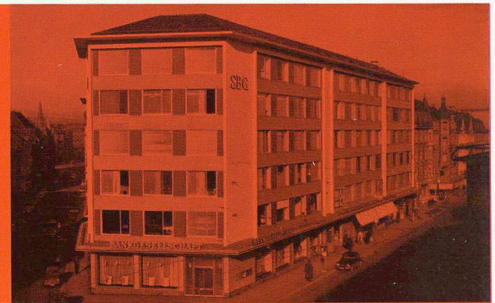
Geschäftshaus Schaffhauserstrasse / Franklinstrasse, Zürich. Arch. Gebr. Pfister, Zürich. Leichtmetallfassade mit Drehflügeln aus Spezialprofilen mit 3fachem Flügelanschlag, Schaufensteranlage und Eingänge.
