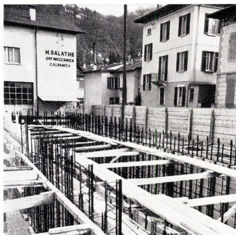
Fixträger für Vertikalschalung
