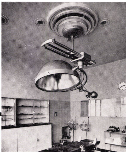
Klimaanlage «System Häusler» in Operationssaal eines Spitals
