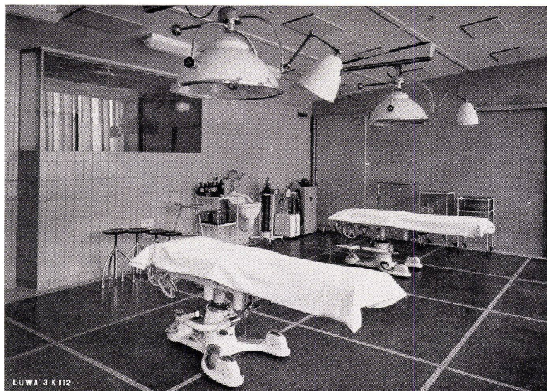
Operationssaal in modernem Spital. An der Decke die Öffnungen für zugfreien Lufteintritt.
