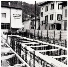
Fixträger für Vertikalschalung
