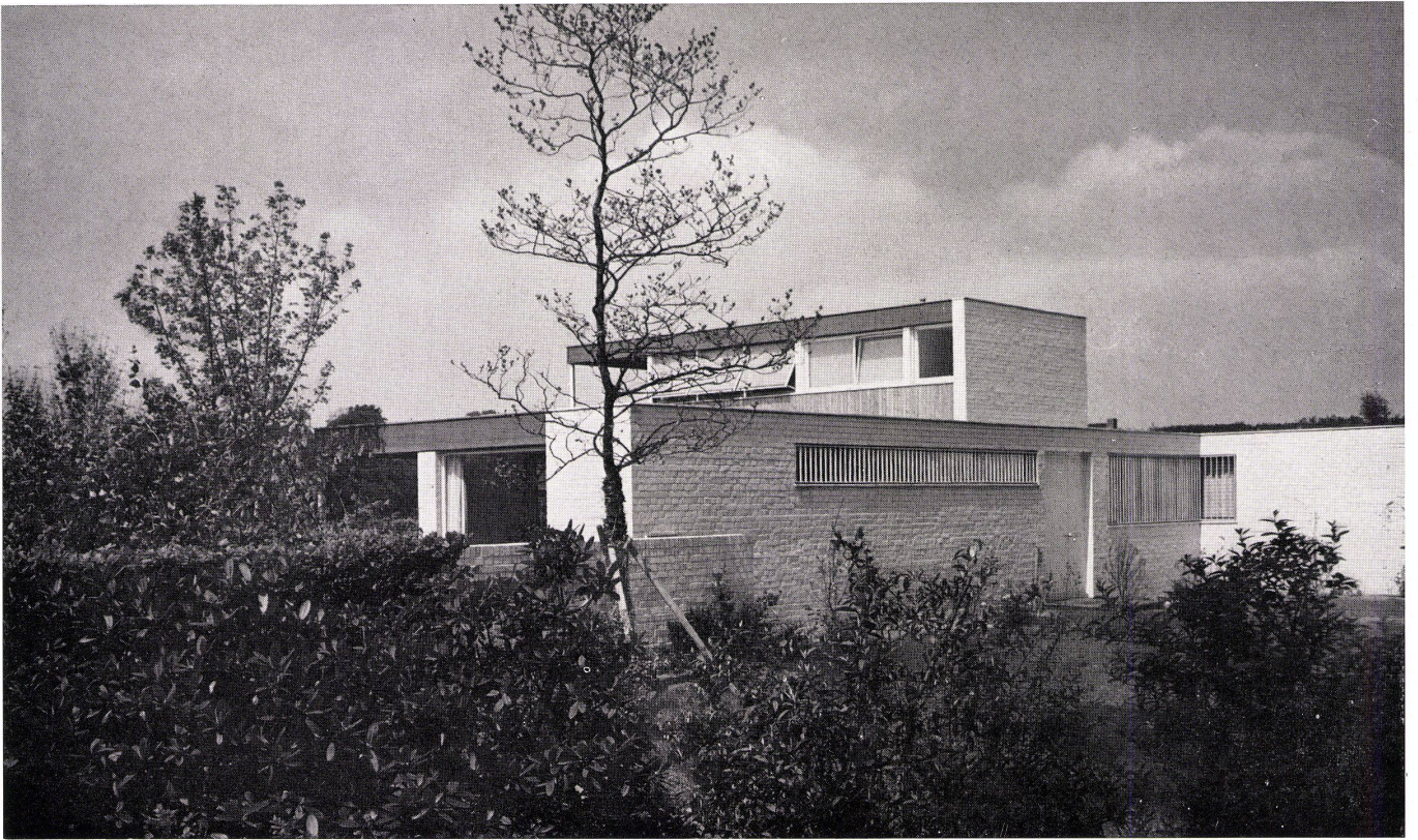
Blick von Nordosten auf Eingangsseite und Obergeschoß- aufbau. Vue du nord-est sur le côté entrée et l'étage supérieur. View from north-east toward entrance side and first floor.
