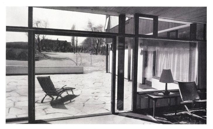
Blick vom Wohnzimmer auf den gegen Westen liegenden windgeschützten Sitzplatz. Die vor den Schiebefenstern und den Außenwänden stehenden Stahlstützen veranschaulichen das Konstruktionssystem.
