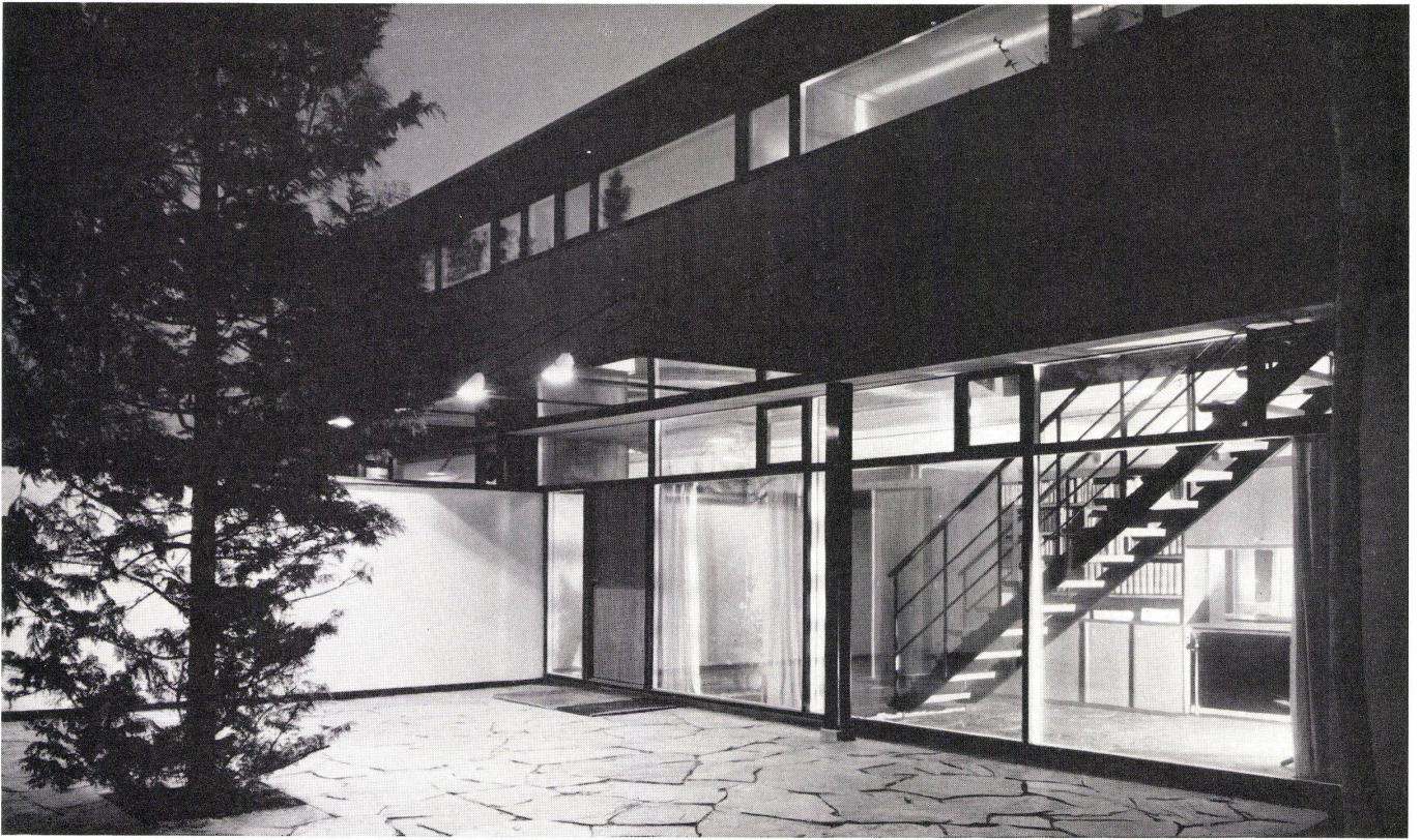
Nachtbild vom Eingangshof aus. Blick in die Eingangshalle mit der Treppe ins Obergeschoß. Vue de nuit prise de la cour d'entrée. Night view taken from entrance court.
