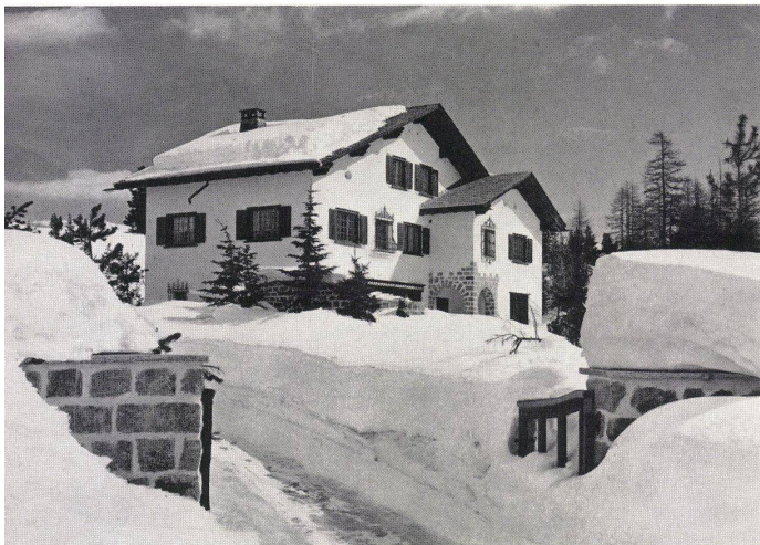
Landhaus im Engadin mit Sulzer-Zentralheizung
