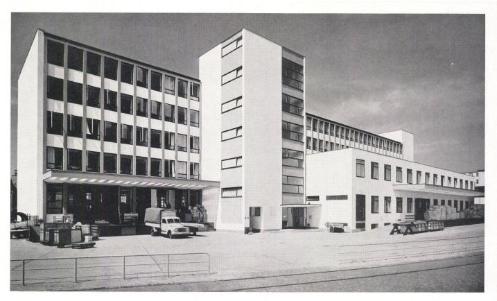
erste Teil einer zirka 35 m tiefen Shedhalle angebaut. Diese Halle ist im Gegensatz zu allen anderen Bauten bei Siemens & Halske in Stahl konstruiert und durch ein Gelenk mit dem Versandbau verbunden. Die senkrechten Shedglasflächen sind typisch für eine Stahlshedkonstruktion. Die Eindeckung der Sheddachflächen erfolgte durch Bimshohldielen auf Stahlfiligranträgern.
