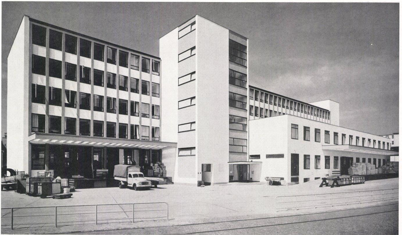
erste Teil einer zirka 35 m tiefen Shedhalle angebaut. Diese Halle ist im Gegensatz zu allen anderen Bauten bei Siemens & Halske in Stahl konstruiert und durch ein Gelenk mit dem Versandbau verbunden. Die senkrechten Shedglasflächen sind typisch für eine Stahlschhedkonstruktion. Die Eindeckung der Sheddachflächen erfolgte durch Bimshohldielen auf Stahlfiligranträgern.
