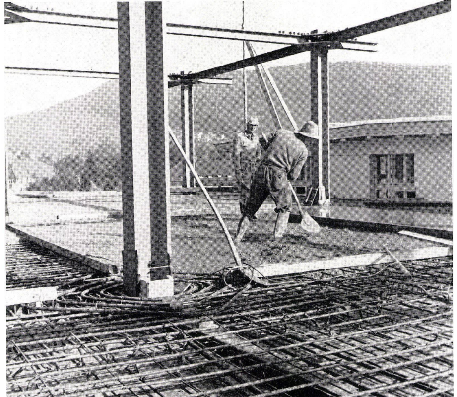
3 Deckenarmierung. Armure du plafond. Ceiling reinforcement.
