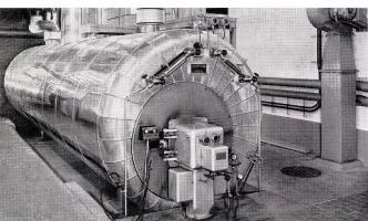
Dampfkesselanlage mit Ölfeuerung System Oertli in einer Lebensmittelfabrik
