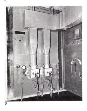
Buss-Eckrohrkesselanlage mit Oertli-Ölfeuerung in einem Industriebetrieb
