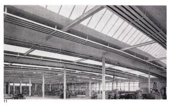
11 Shedbau mit hochliegenden Bandstrahlern der Sulzer-Hochtemperatur-Strahlungsheizung
