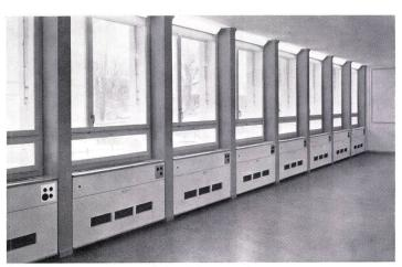
Büroraum mit eingebauten Sulzer-Klimakonvektoren
