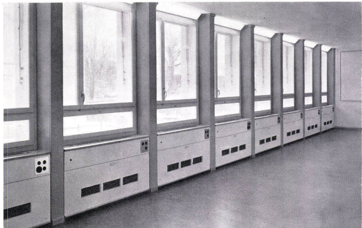
Büroraum mit eingebauten Sulzer-Klimakonvektoren
