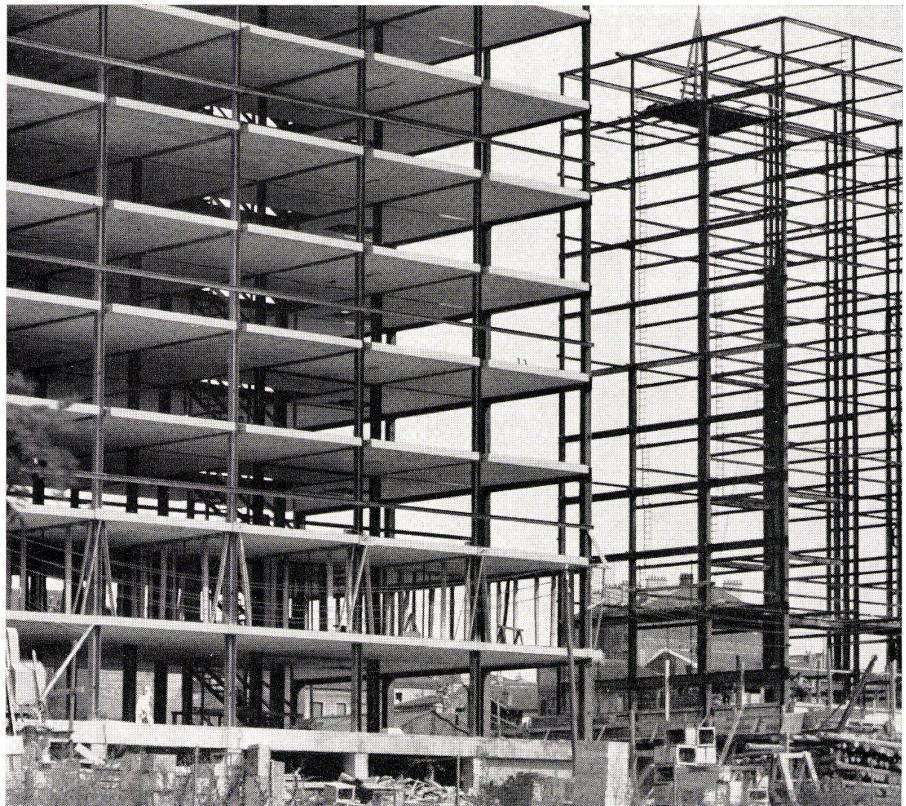
Keller und Erdgeschoß sind in Eisenbeton ausgeführt. Das Stahlskelett nimmt alle vertikalen und alle Windkräfte auf. Es besteht aus Querrahmen, welche in der ganzen Höhe der Häuser, d. h. elf Stockwerke hoch, in einem Stück geschweißt und aufgestellt wurden. Provisorische Spannriegel gewährleisteten die Stabilität während der Montage.
