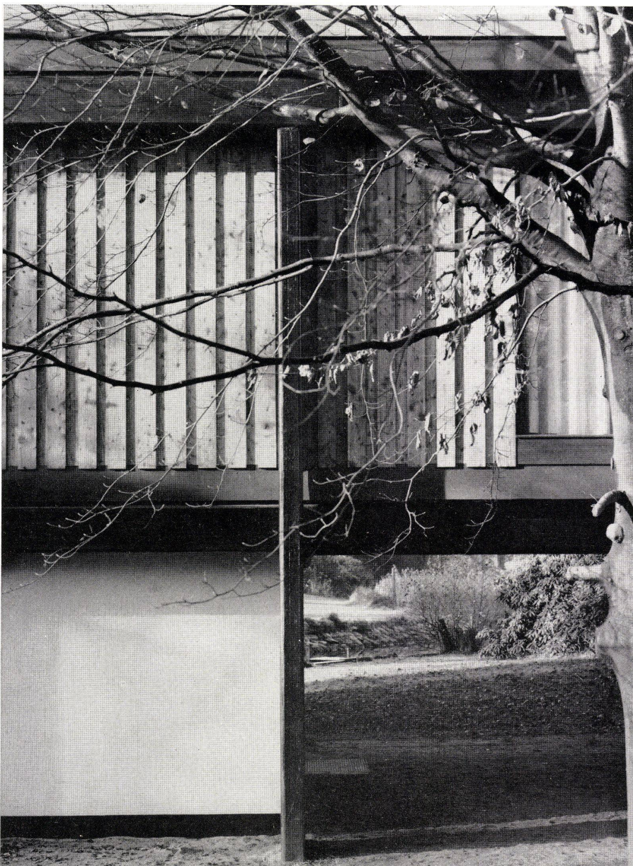
Detail der Ostwand mit Holzfüllelementen. Détail de la paroi est avec éléments de remplissage en bois. Detail of east partition with wood panel elements.
