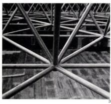
Okta-Stahlrohr-Tragwerk / Charpente Octa en tubes d'acier / Octa Steel Tubular Framework
