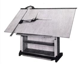
Neuer Zeichenständer «Rüedi», Modell B1, mit Laufwerk-Zeichenmaschine, Chassis mit Brett bis  $30^{\circ}$  stufenlos neigbar. Brett in jeder Stellung parallel zum Chassis verschiebbar. Minimale Platzbeanspruchung. Vorderseite: Ständer mit Tablar und bequemer Fußstütze. Anstellmöglichkeit gegen jedes Pult oder jeden Schreibtisch. Auch in Spezialausführungen erhältlich.
