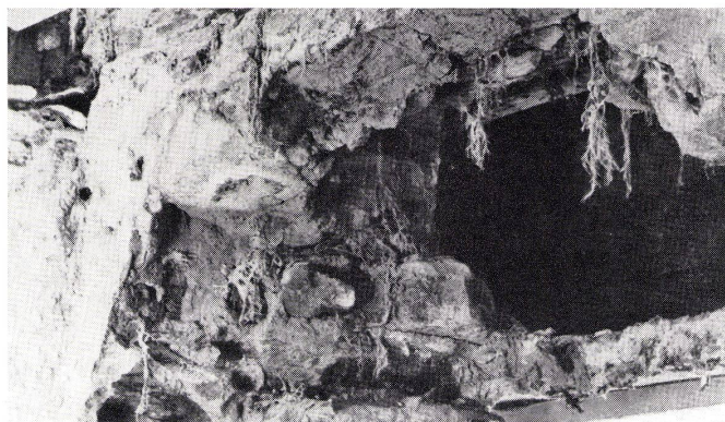
Durchbrochene feuchte Mauer, verseucht durch Pilzstränge des Hausschwammes, in die Bresche herabhängend.
