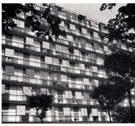
In der Ecke zwischen Corso Sempione und Via Mussi stand ein im wesentlichen dreieckiges Grundstück zur Verfügung der Architekten. Um Grünraum vor dem rückwärtigen Flügel zu erhalten, bauten diese den an Via Mussi liegenden Hausteil zurückgesetzt und nicht auf die Baulinie. So entstand ein T-förmiger Gesamtgrundriß. Drei Treppenhäuser bedienen pro Geschoß jeweils sieben Wohnungen, wovon das im Winkel der beiden Bauteile liegende Treppenhaus drei Wohnungen erschließt.
