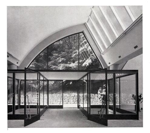
wurden mit Thermopane-Kristall-Spiegelglas und die wärmeisolierten Brüstungsfelder mit schwarzem Opalglas verglast. Für den Sonnenschutz wurden Leichtmetall-Lamellenstores verwendet. Die übrigen Skelettaußenwände sind — soweit nicht verglast — mit 24 cm starkem Ziegel-Holstein-Mauerwerk ausgefacht, innen verputzt, außen mit Klinkerplatten verkleidet und umlaufend mit Prestik gedichtet.
