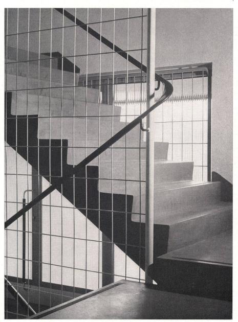
Treppenhausdetail. Stufen in Eisenbeton mit grünem Duratexbelag. Handlauf in Mipolam.
