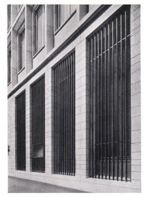
Die 4,2 m hohen Fenstergitter mit eingebauten Schaukasten. Gitter und Vitrinen-Rahmen sind aus stranggepreßten Bronze-Profilen zusammengebaut.
